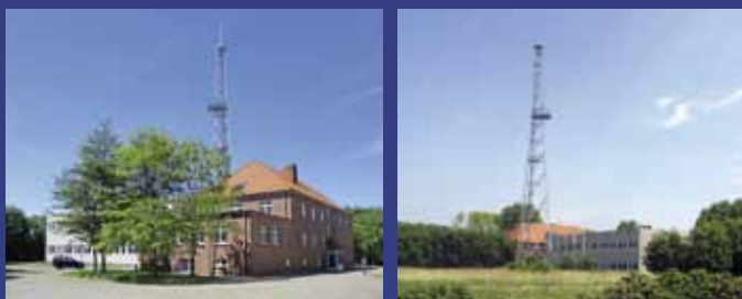
Empfangsfunkstelle Norddeich Radio Utlandshörn
