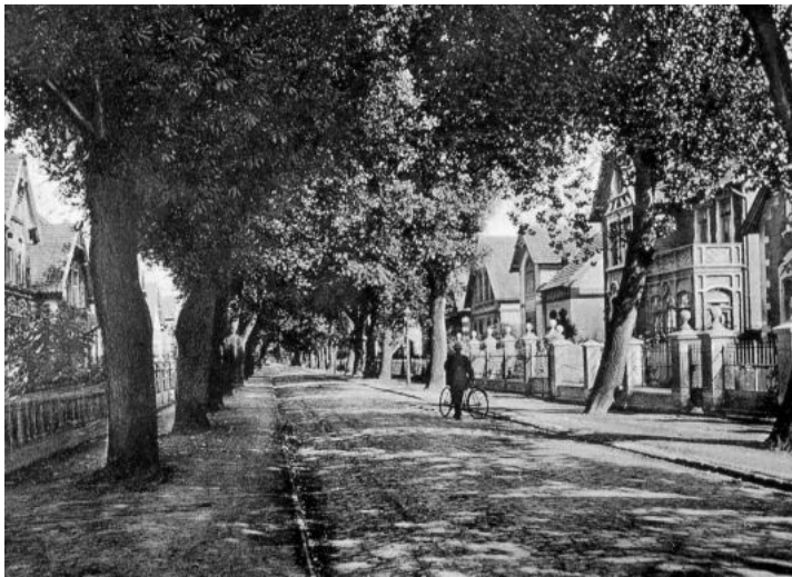
Abb. 127: Norddeicher Straße – Vergangenheit Quelle: Archiv Medienzentrum Norden
