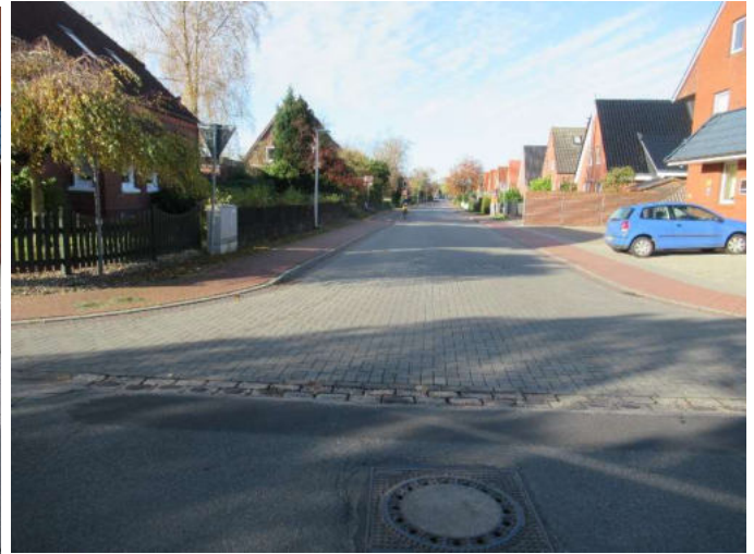
Abb. 116: Nordseestraße nach dem Umbau
