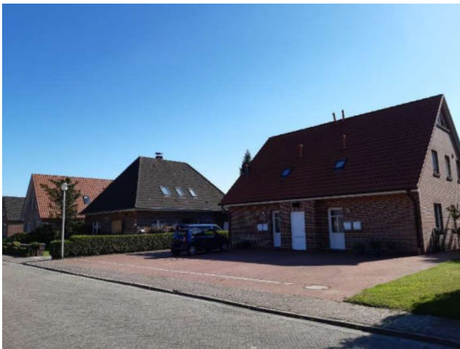
Abb. 195: vollständig versiegelter Vorgartenbereich
