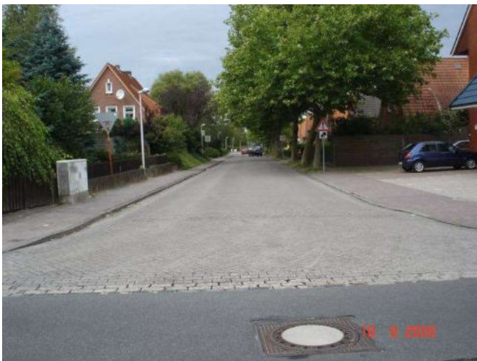
Abb. 115: Nordseestraße vor dem Umbau
