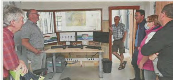
Auch einen Einblick in die Technik des vor 60 Jahren errichteten Schöpfwerkes wurde gewährt. In den Redebeiträgen ging es hauptsächlich um das Umdenken in Sachen Entwässerung.
