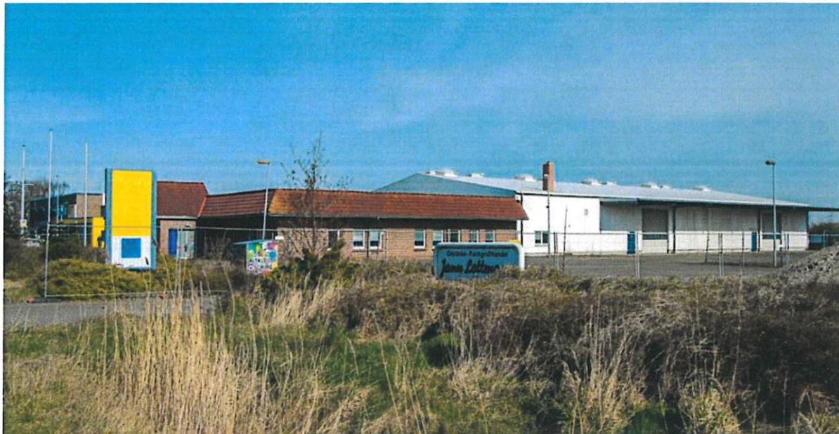
Blick von der Norddeicher Straße auf die vorhandene Zufahrt zur Plangebietsfläche (Bestandsgebäude Getränkemarkt)
