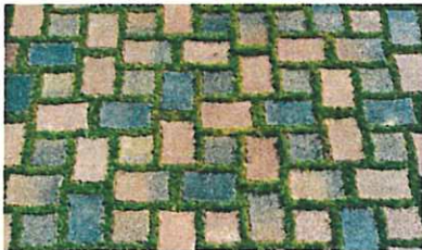
Bsp. wasserdurchlässiges Pflaster
