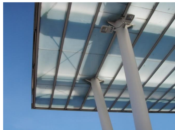
Abb.: Lofer, Detail der transluzenten Dachkonstruktion
