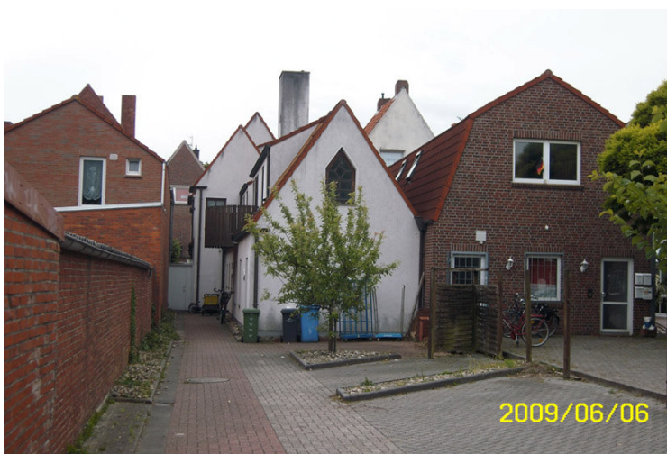
Bild 22: Neuer Weg: rückwärtige Bebau- ung Ostseite
