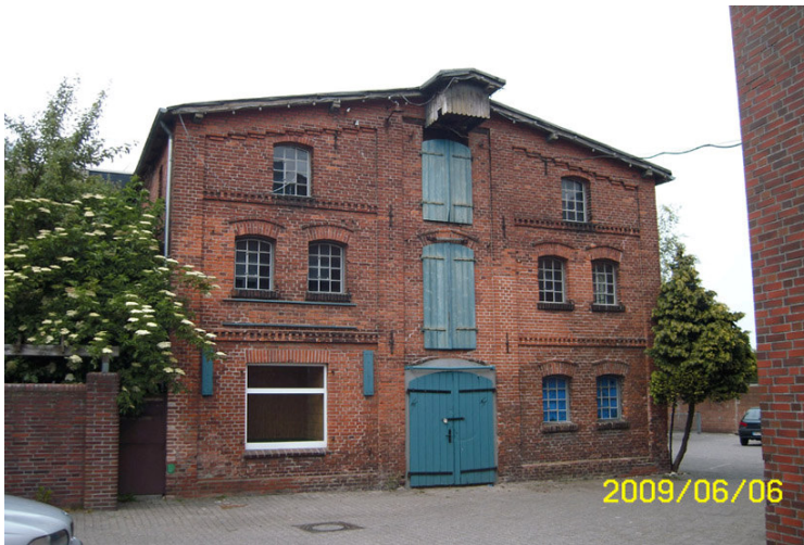
Bild 20: Osterstraße 11: rückwärtiger Speicher,
