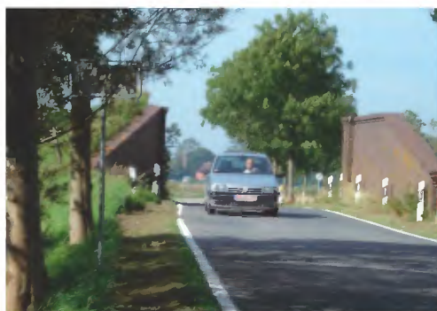
Deichschart/Deich- durchfahrt, Straße Störtebeker Riede
