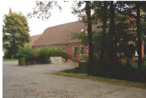
Nebengebäude Schule: Sanitäranlagen, Woh- nungen
