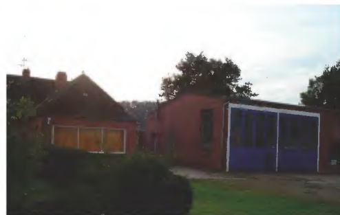
Ehemaliges Werkstattgebäude (Maschinenhandel)
