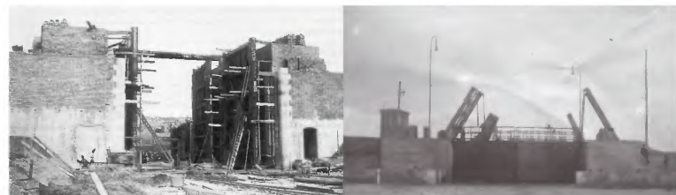
Das alte Sielbauwerk im Bau (1929) und bei der Arbeit
