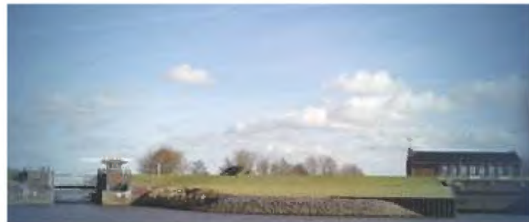
Das neue Schöpfwerk und Sielbauwerk
