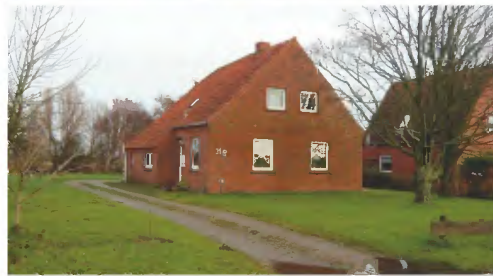
Giebel im Bereich des Wohnteils
