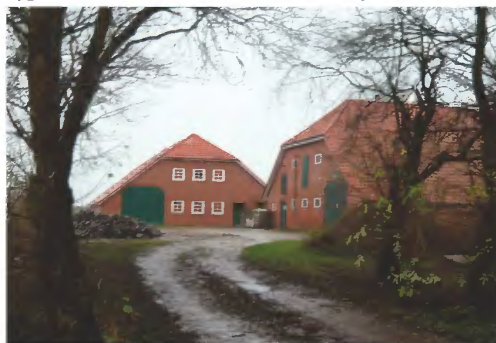
Die Giebel des Wirtschaftsteils sind meistens mit einem Krüppelwalm ausgebildet.
