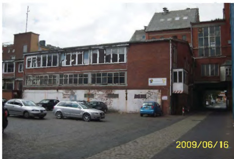
Bild 11: Alte Betriebsgebäude an Doornkaatlohne
