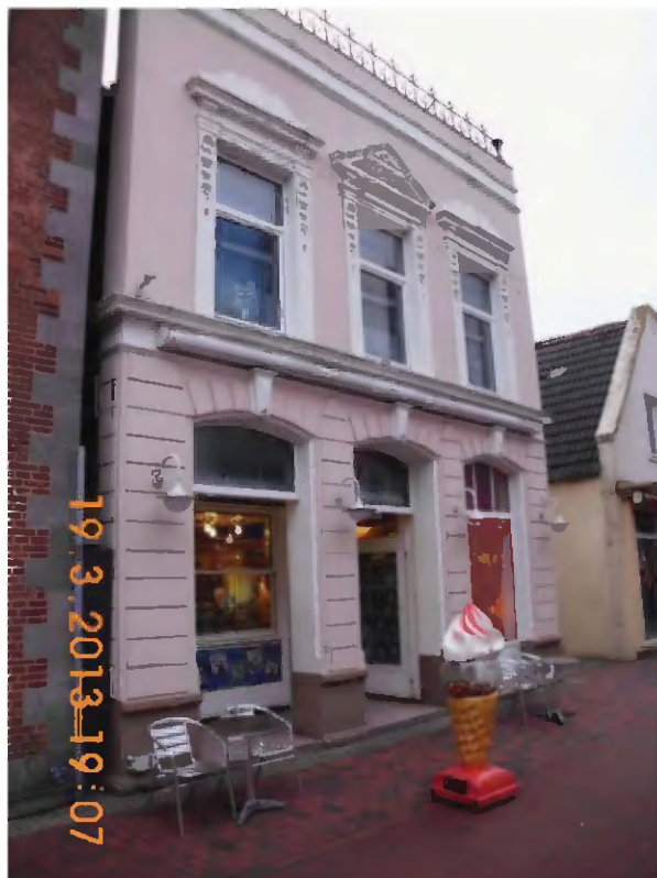
Bild 30: Neuer Weg 93, vorhandene Bodenständigkeit
