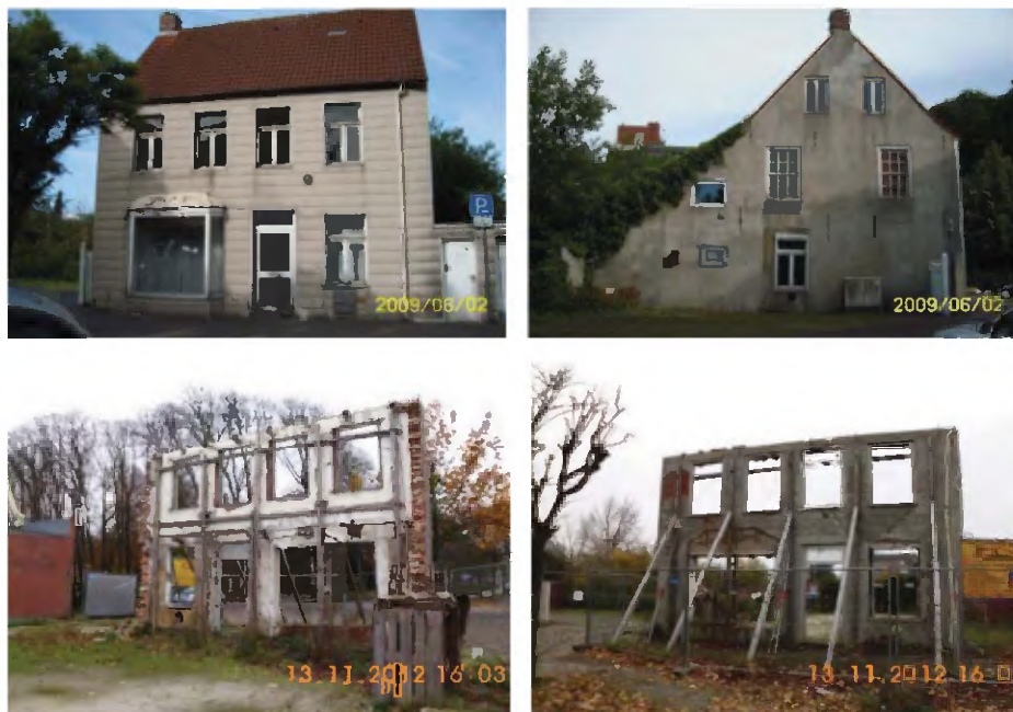
Bild 2-5: Am Markt 67, restliche Fassade 2013 abgebrochen
