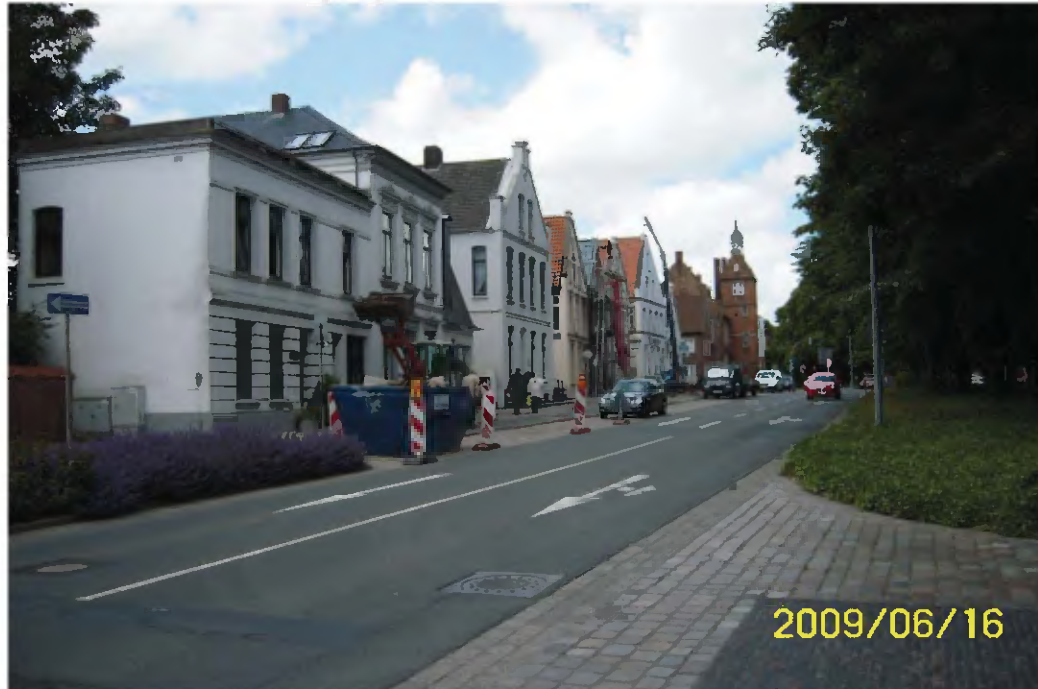
Bild 21: Durchgangsstraße Am Markt - Westseite
