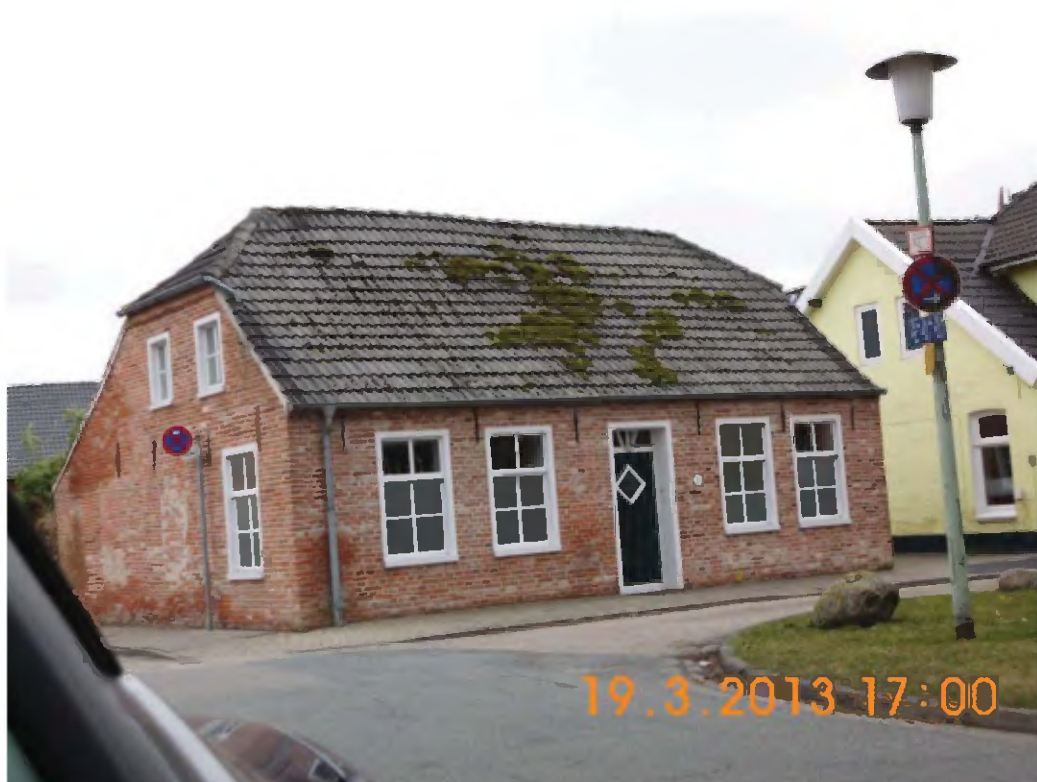
Bild 15: Erfolgreiche Sanierung, Fräuleinshof 7
