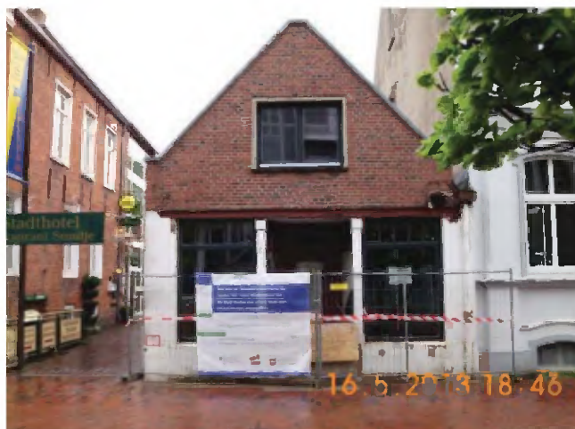
Bild 08: Neuer Weg 90 vor der Modernisierung
