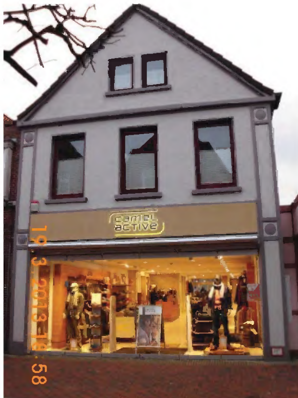
Bild 29: Neuer Weg 22, fehlende Bodenständigkeit
