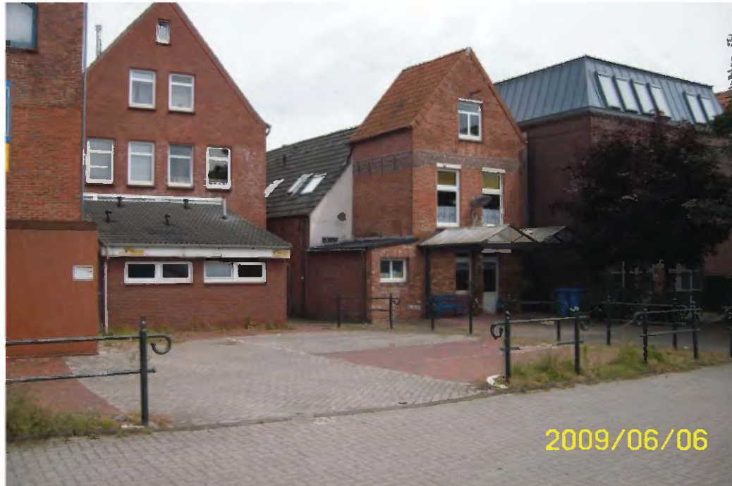
Bild 25: Rückansichten und Freiflächen Neuer Weg Nr. 115 und 114
